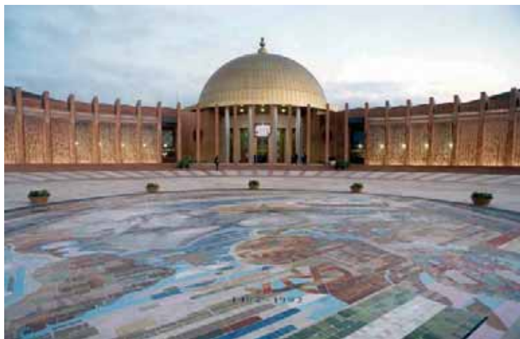
Entrada principal y detalle del patio del Palacio de Congresos y Exposiciones de Sevilla, sede de Technimap 2006.
